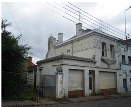
Non décent (avant travaux)
