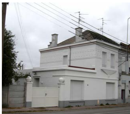
Décent (après travaux)
