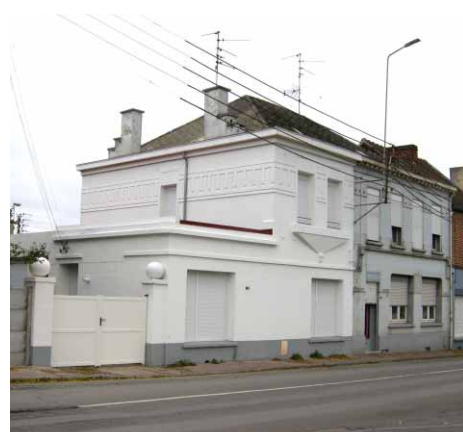
Parc privé : exemple de réhabilitation
