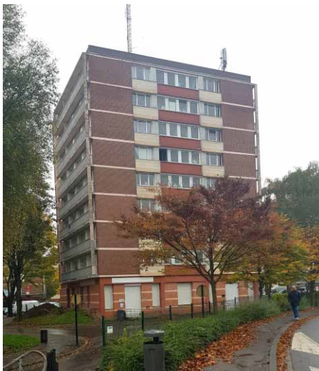
Réhabilitation thermique en BBC de la résidence Dampierre à Valenciennes (SIGH)
