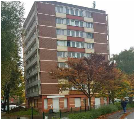
Réhabilitation thermique en BBC de la résidence Dampierre à Valenciennes (SIGH)
