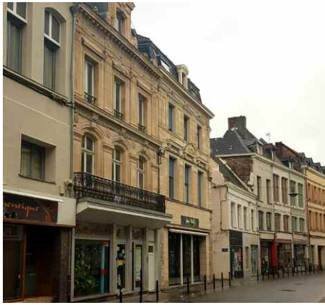
Réhabilitation de façades rue de Lille - Valenciennes
