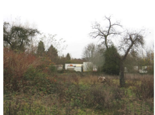
b) La friche des services techniques
